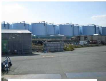
処理水タンク
