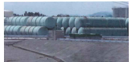
フェーシング加工された法面
