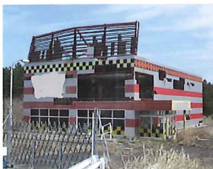
放置されている建物
