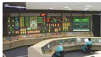
中央制御室。タッチパネルが並ぶ
