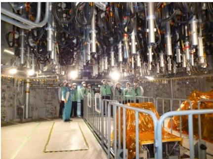
原子炉圧力容器の真下で。銀色の筒には制御棒が納められ、多数のセンサーケーブルが見える
