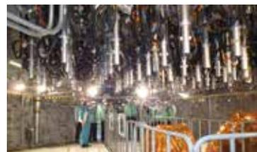
原子炉压力容器の真下で。銀色の筒には制御棒が納められ、多数のセンサーケーブルが見える
