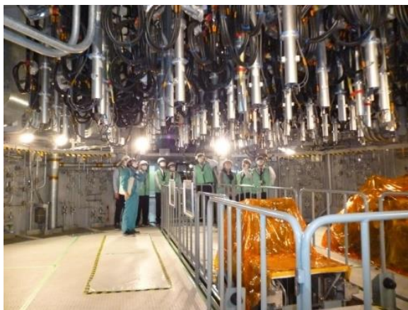
原子炉压力容器の真下で。銀色の筒には制御棒が納められ、多数のセンサーケーブルが見える
